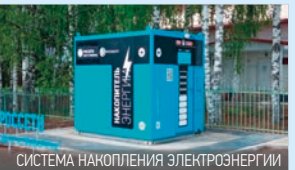
СИСТЕМА НАКОПЛЕНИЯ ЭЛЕКТРОЭНЕРГИИ
