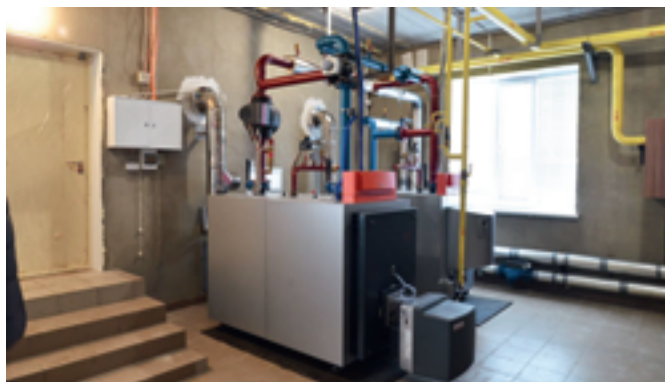
Рисунок 11. Татарстан, г. Набережные Челны, Гостиница «SKY LUX HOTEL», Vitoplex 300 – 300 кВт и Vitocrossal 200 – 311 кВт
