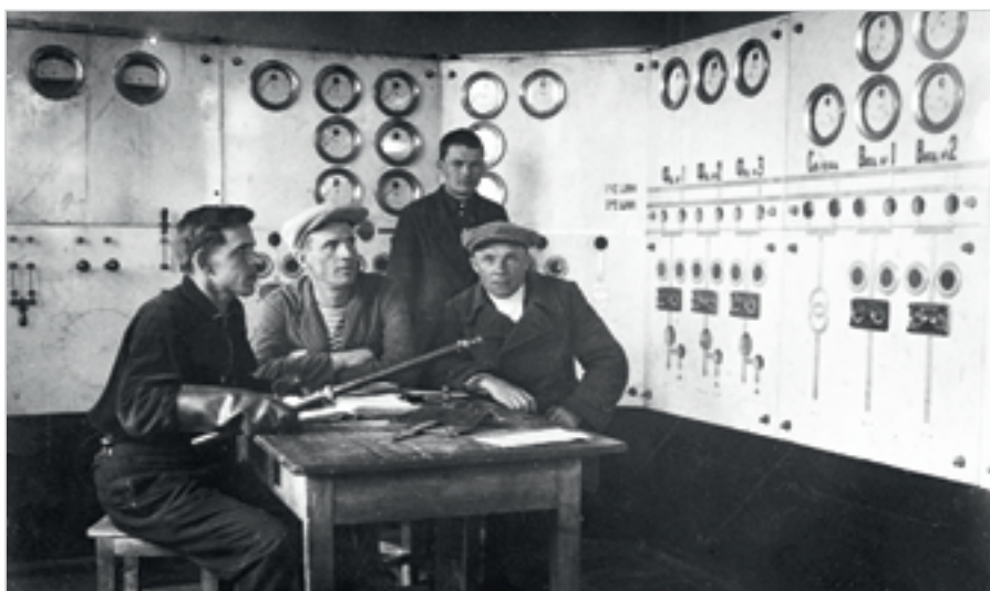
Щит управления ПС «Фидерная»
