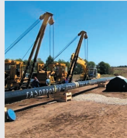
Газопровод построен в деревне Новый Пинигерь
