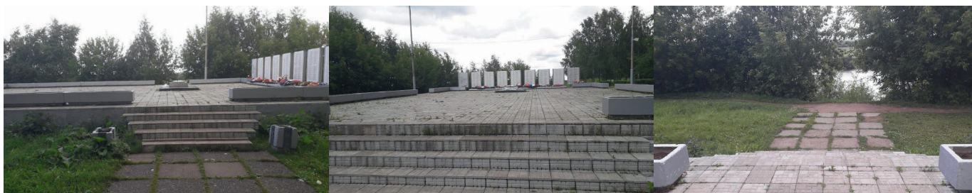
Последний косметический ремонт был в 2009 году
