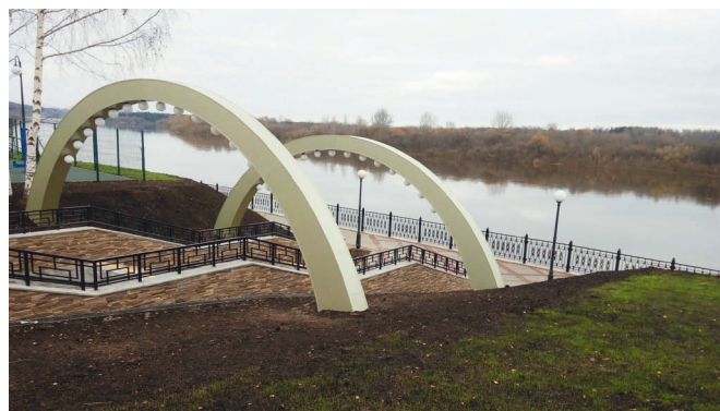
устройство входной группы
