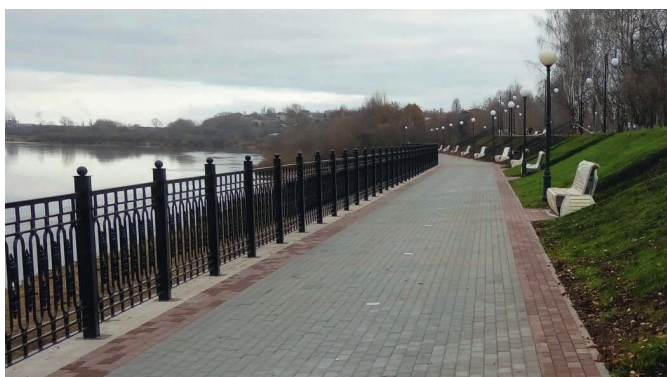
реставрация ограждения вдоль нижней набережной
