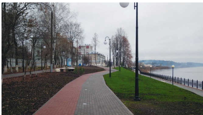
устройство новых пешеходных дорожек верхней набережной
