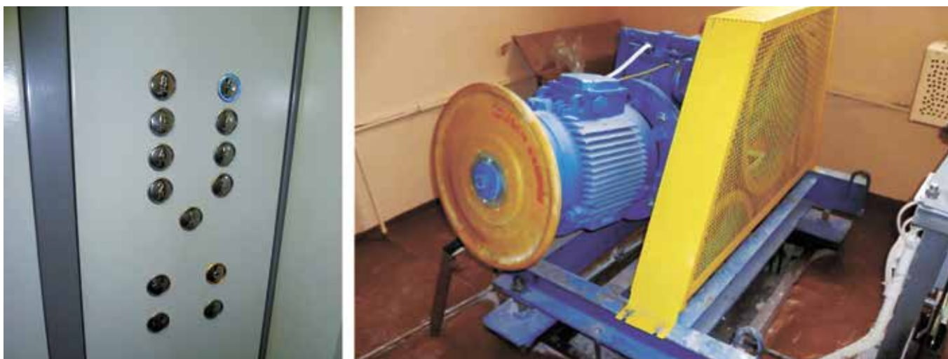
Фото после ремонта
