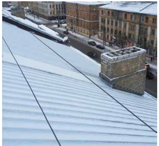
Фото после ремонта
